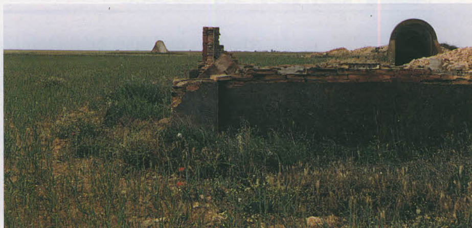
Estado actual del «Campo de Aviación» en Santa Cruz de la Zarza.
